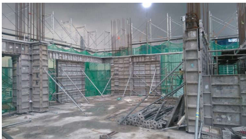
70.000 Cây chống/ Scaffolding System
