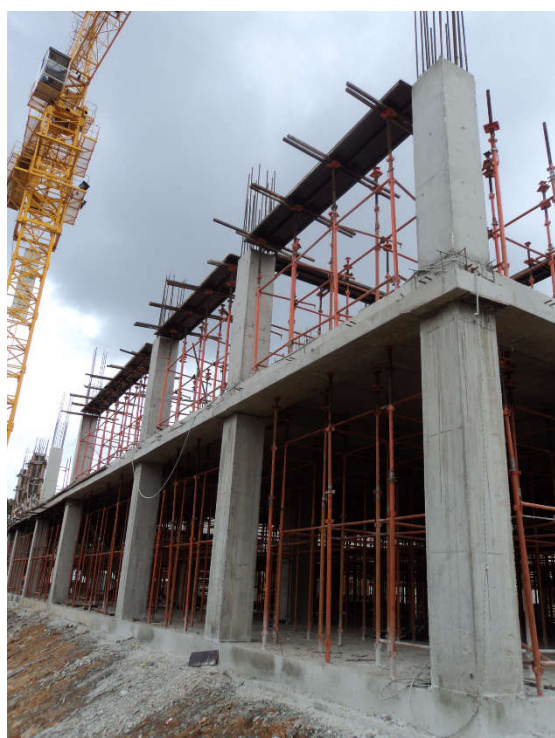
50.000m 2 Ván khuôn – đà giáo/ Formwork
